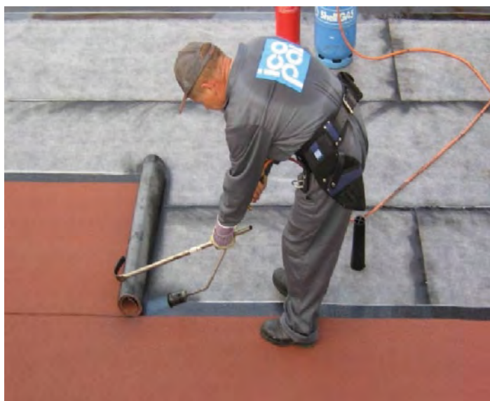
Рис. 13 Укладка верхнего слоя материала наплавлением
