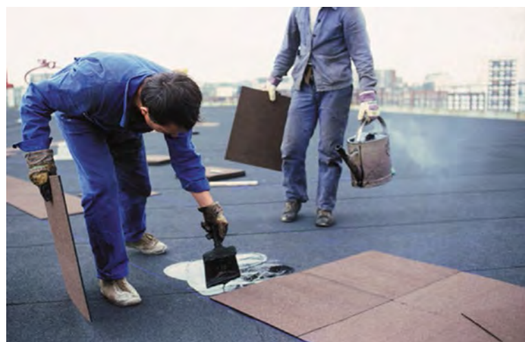
Рис. 12 Укладка плиток Dalle Parcour
