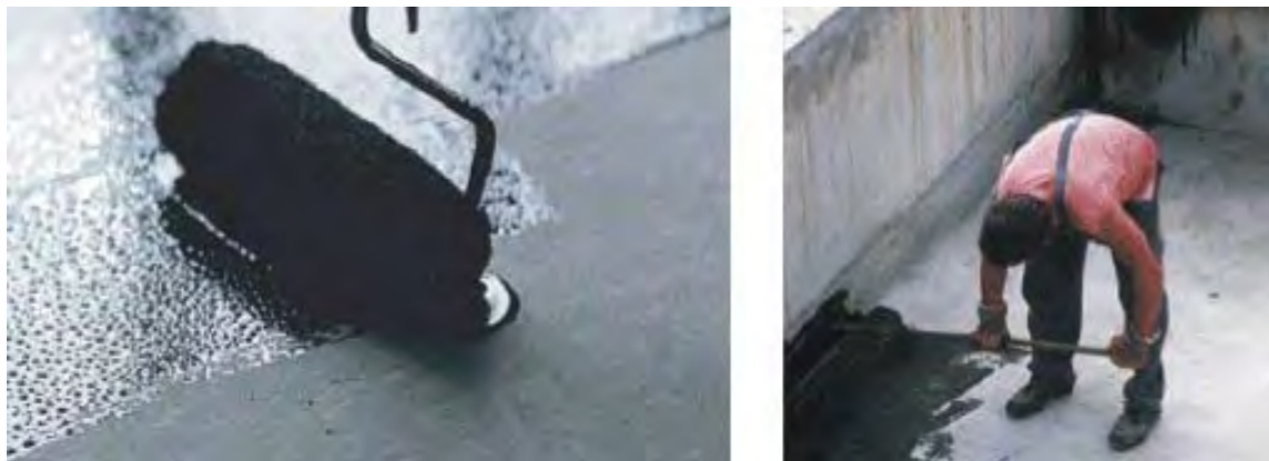
Рис. 5 Нанесение праймера
